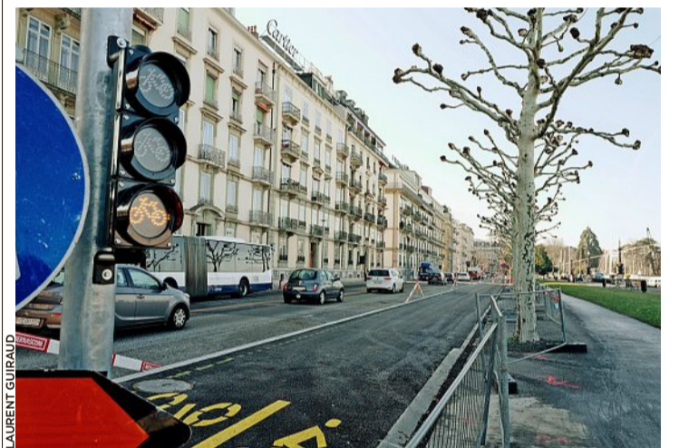
Piste cyclable bidirectionnelle sur le quai Gustave-Ador, similaire à celle qui sera créée sur la Rive droite.
